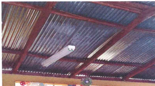
Foto 4: Sustrucción de estructura de soporte de madera por metal en modulo de aulas 1
