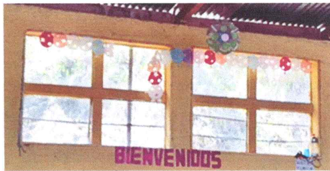
Foto 8: Sustrucción de ventanas de madera por metal mas vidrio en modulo de aula 1
