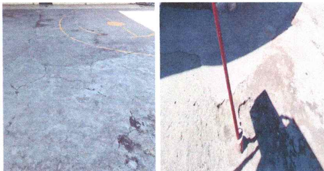
Foto 10: Reparación de losa del patio de la escuela.
