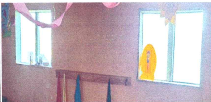
Foto 9: Sustrucción de ventanas de madera por metal mas vidrio en modulo de aula 2
