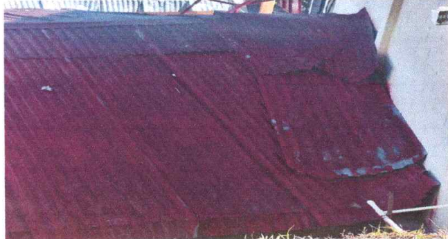
Foto 1: Sustrucción de lámina por lámina troquelada en modulo de aulas 1.
