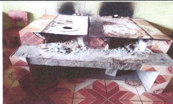
Foto 12: Sustrucción de planchas de metal 3 hornillas.
